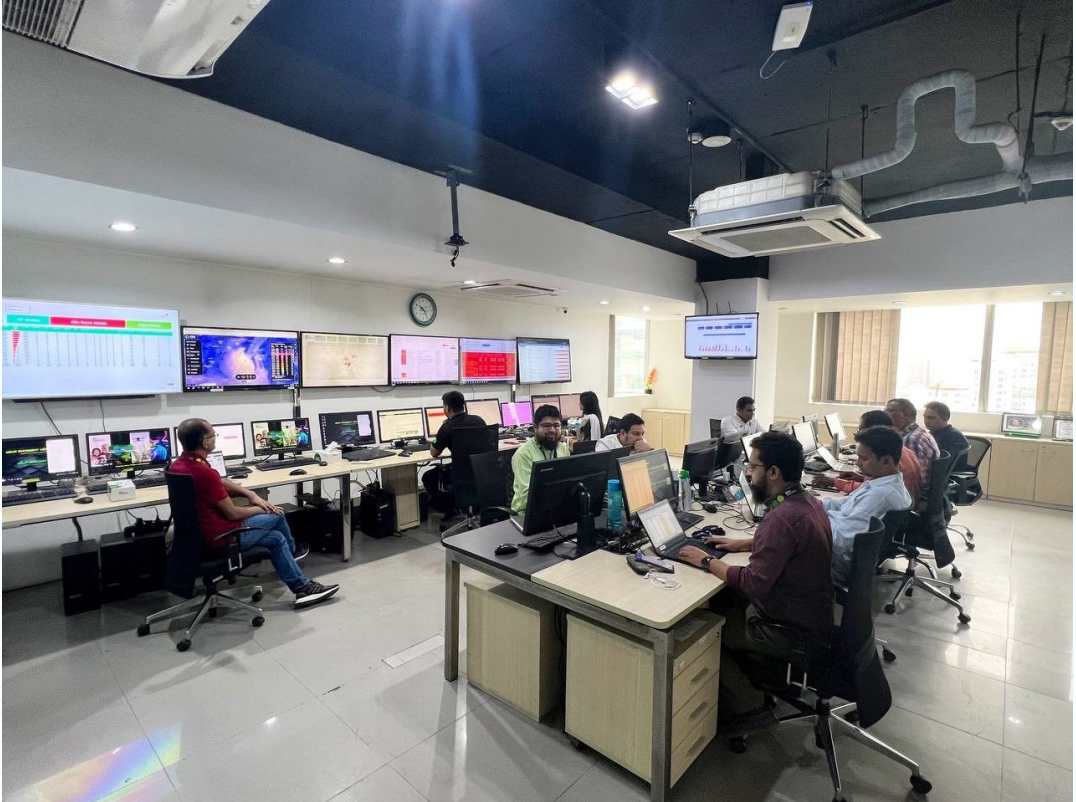
বিটিআরসি'র Emergency Response Control Room
